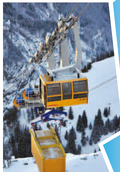
Bauseilbahn 1 trägt den Baucontainer ins Gebirge.
