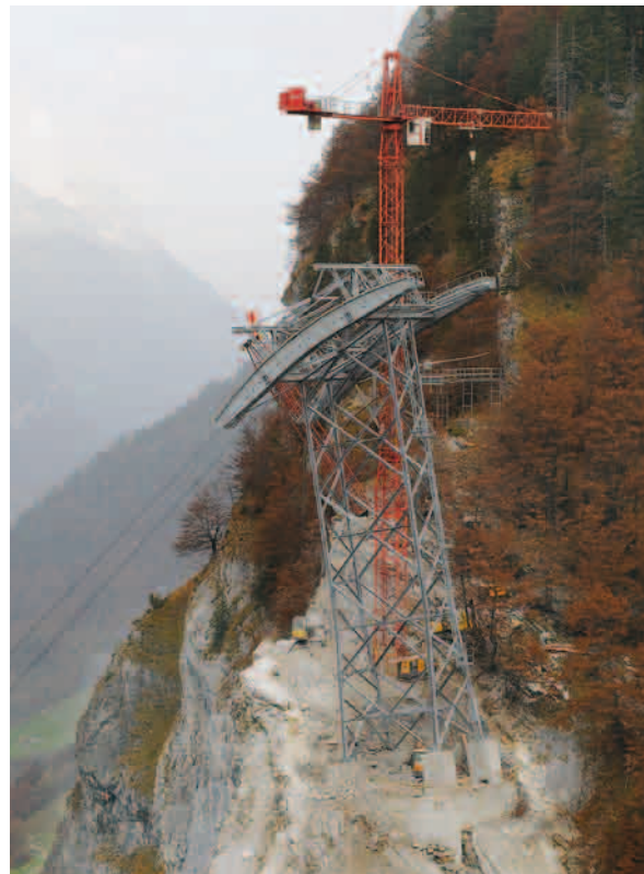
Exponiert ragt die Stütze 1 über den Felsen.
