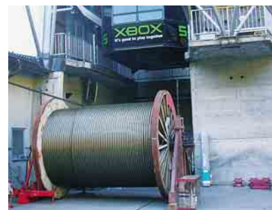
Seilzug für die Luftseilbahn Mulania-Grap Sogn Gion.
