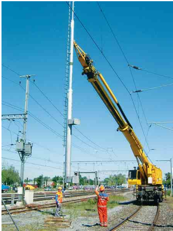
Ob mit Helikopter, Strassentransporter oder mit Bahnfahrzeug – die GSM-Masten werden durch die Inauen-Schätti AG montiert.
