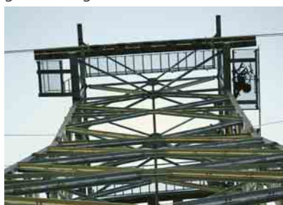
Neukonstruktion der Stütze
