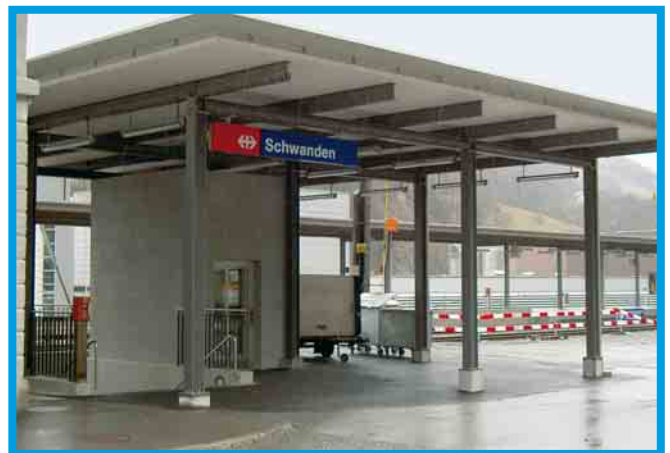
Stahlkonstruktion für die Eingangspassage Kundencenter SBB
