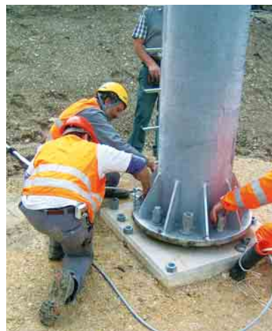
Perfekte Zusammenarbeit – in zwei Stunden steht ein Mast.
